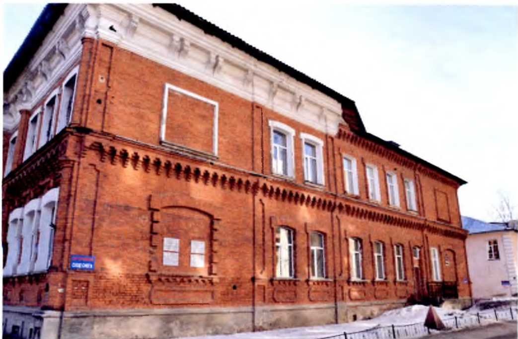
Фото 2. Правый боковой фасад здания
